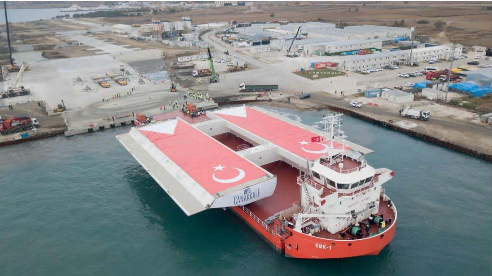
1915 Çanakkale Köprüsü Tabliyelerinin Taşınması Projesi
